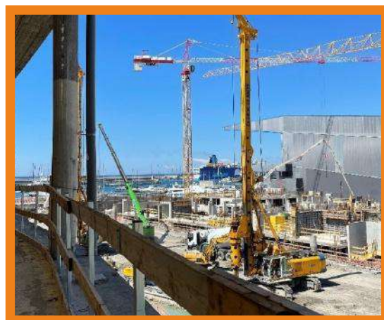
Figura 2 Cantiere Waterfront di Levante
