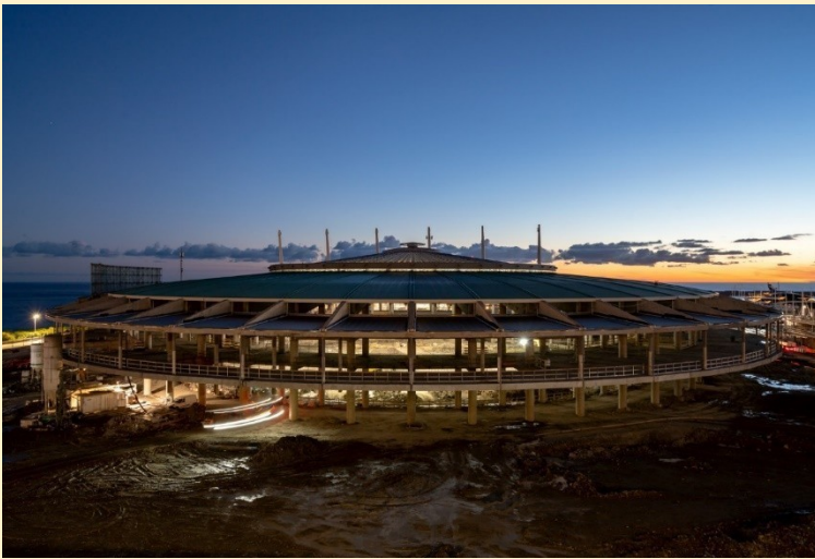
Figura 2 Il palazzetto dello sport
