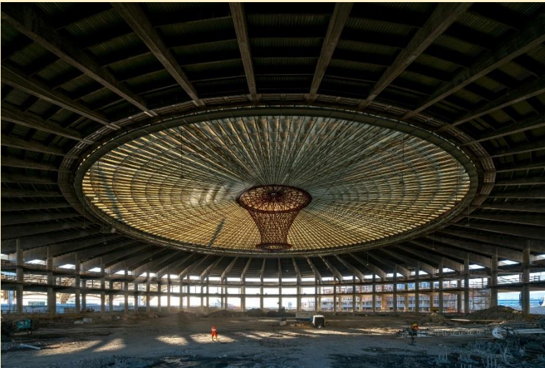
Figura 2 Il palazzetto dello sport
