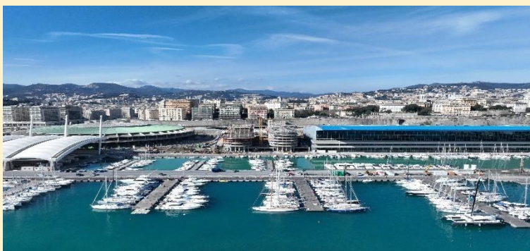
Figura 1 Costruzione del Waterfront di Levante
