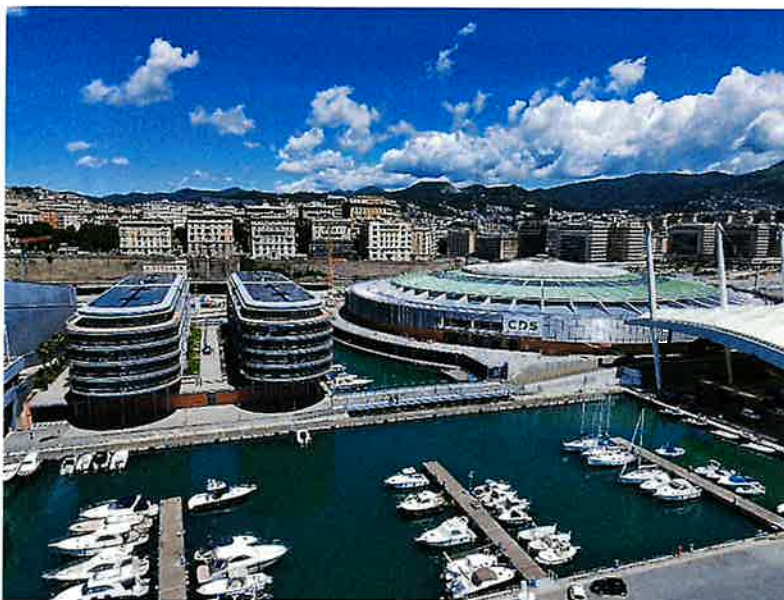
Figura 1 Costruzione del Waterfront di Levante
